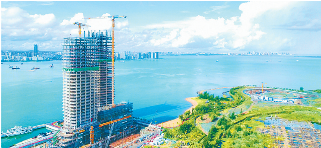
2021年10月7日,由中国建筑第八工程局有限公司海南分公司承建的华彩·海口湾广场项目顺利完成A座楼主体结构封顶,标志着项目主体结构全面封顶。这是海口装配式钢结构建筑领域的首个全钢结构项目。(图片来源:海南日报)
