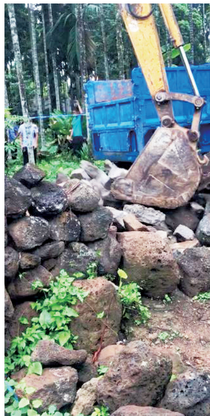
土堆石块清除现场。
