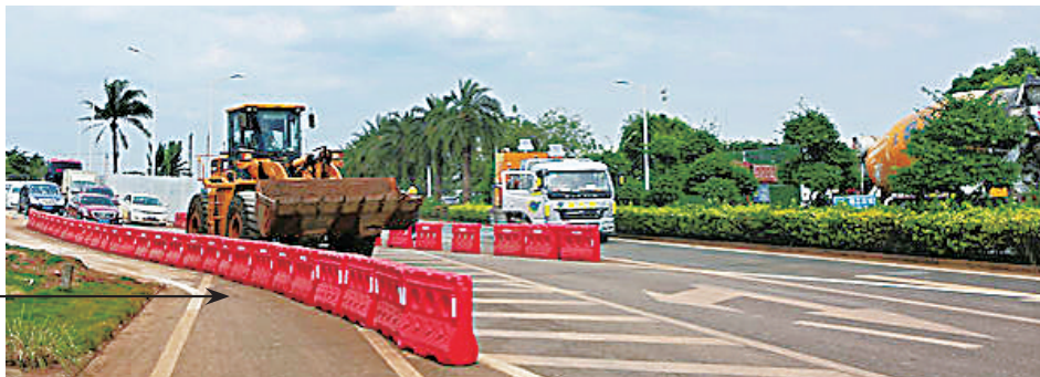
美兰机场西进场路开始封闭施工。(机场供图)
