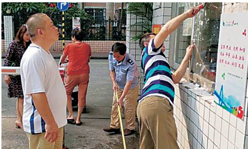
龙华区一小区正在进行整改。(金贸街道办供图。)
