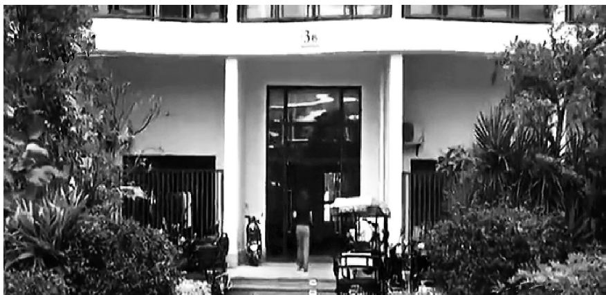
开发商将11栋住宅楼的一层架空层封堵建房。
