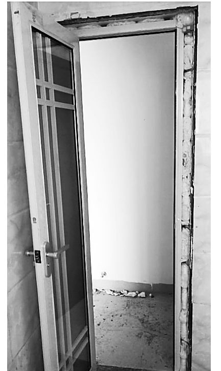
门与门框缝隙偏大。(市民供图)
