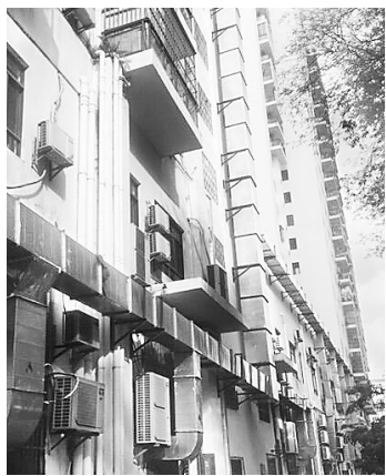
商铺已规范安装油烟排烟道
