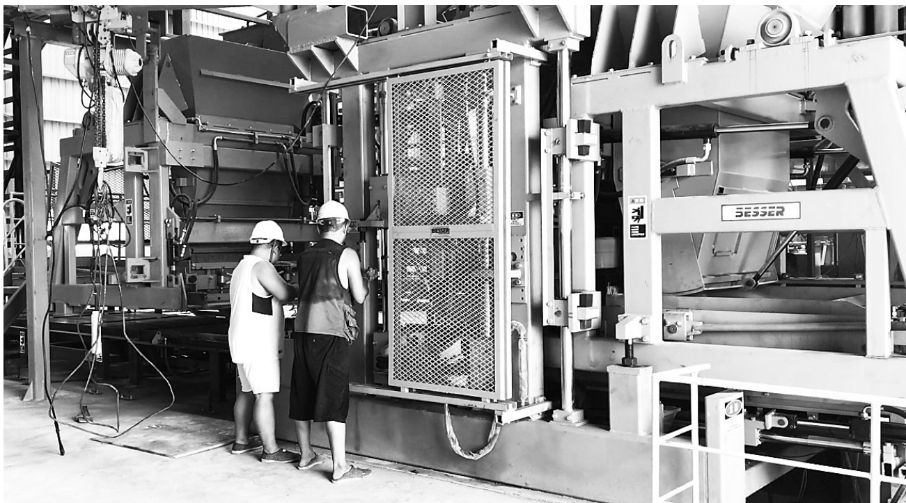
工作人员正在对生产机器进行维护。
