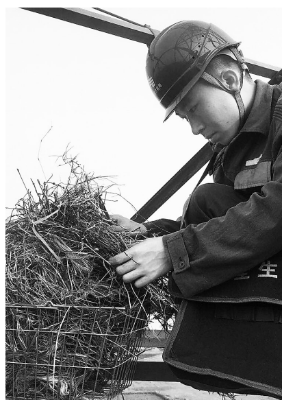
工作人员在安装人工鸟巢。(高弋崧摄)
