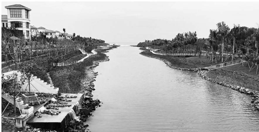
五源河湿地公园出海口示范段改造初具成效。
