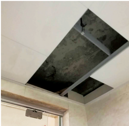
8楼卫生间顶部还在修复中。
