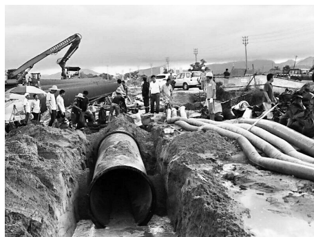
原水暗涵抢修现场。
