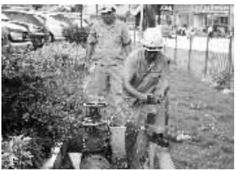
检修人员在排查断水原因
